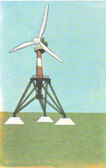
المحرك الهوائي الاختباري الكبير، يدير مولدة كهربائية .
